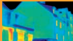
Die Thermographie zeigt deutlich den Wärmeverlust an den rotglühenden Stellen der Hauswand.
